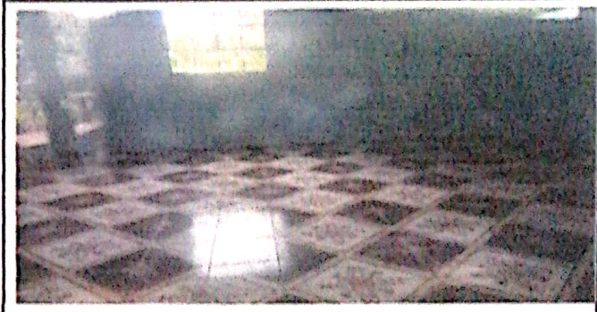
Foto 4: Cambio de piso
